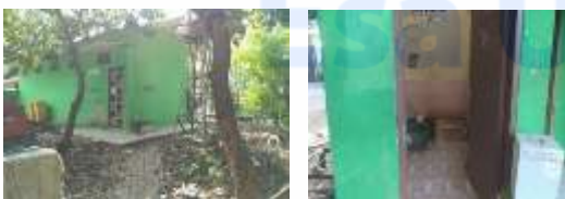
Gambar 6 Kondisi Toilet Umum
